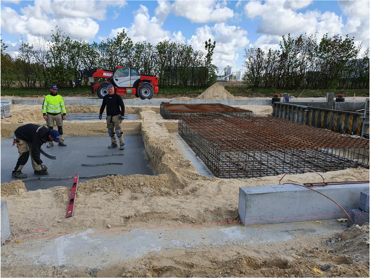
Maskinfundamentene støbes
