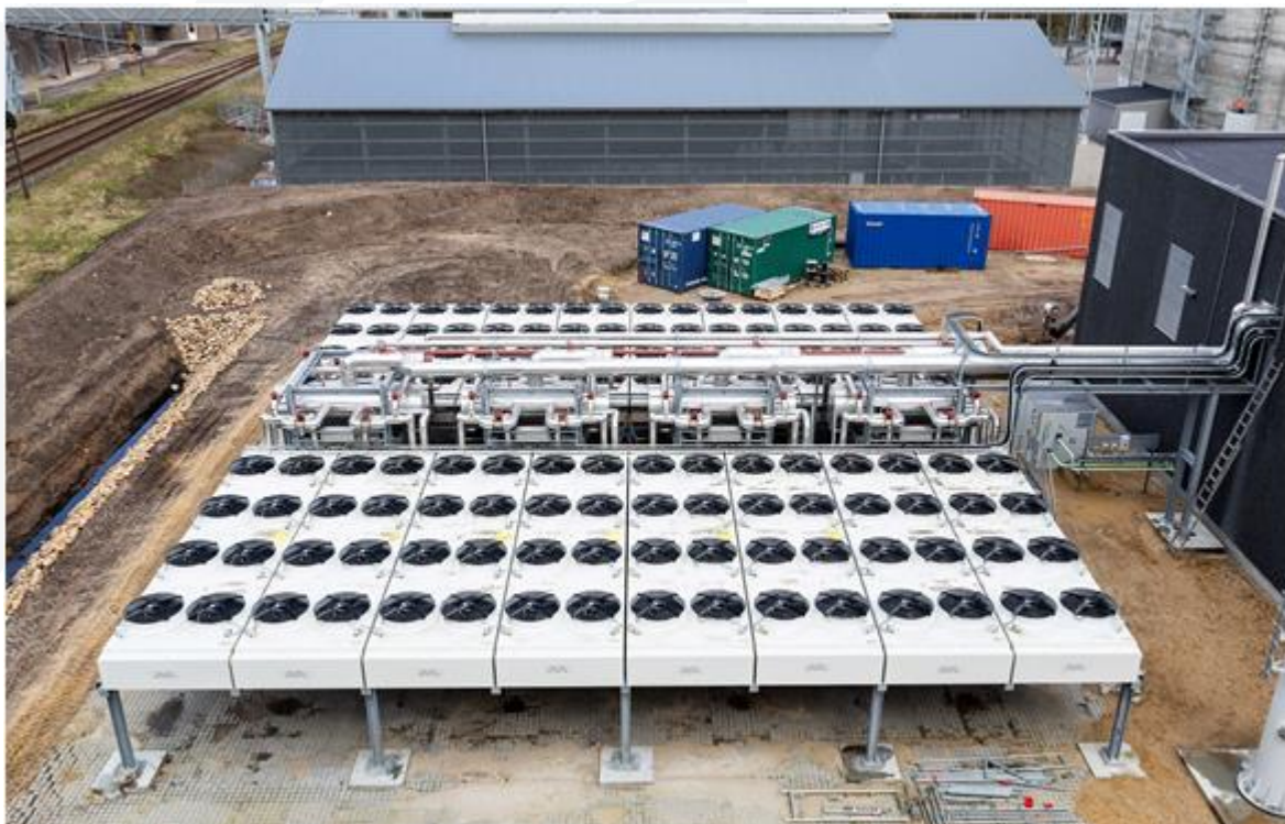
32 luftkølere opført hos Brande Varmeværk
